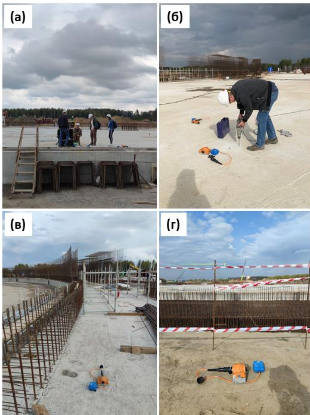
Рис. 2. Процесс установки сейсмических датчиков
